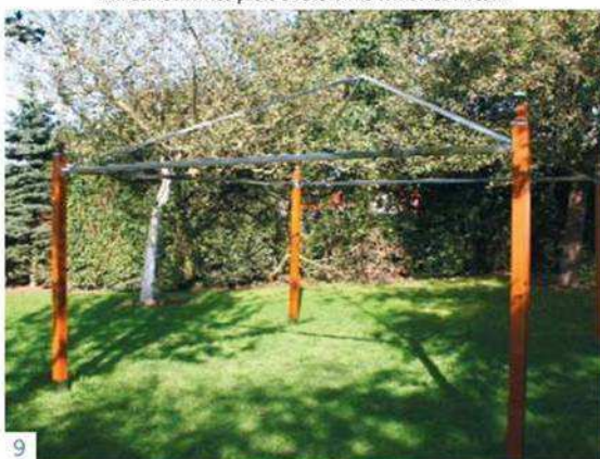
Armature montée prête à recevoir le toit et les rideaux
