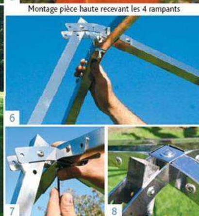
Montage pièce haute recevant les 4 rampants
