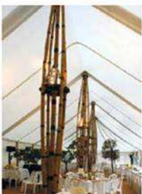
1 mât tous les 5 m = mât en ligne
